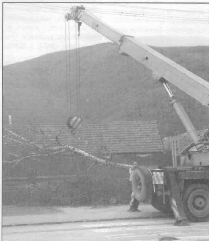
Odstraňovanie stromov na autobusovej zastávke
